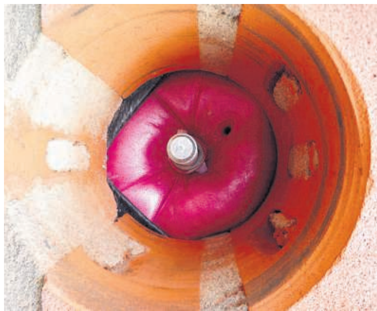
Zo ziet een aangebrachte spouwdonut eruit.
