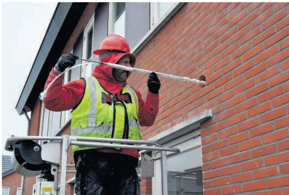
Een bouwvakker is bezig met het aanbrengen van een spouwdonut.
