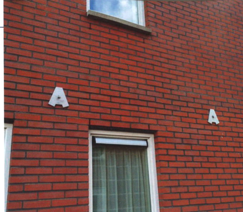
Eindresultaat van een van de testwoningen, te herkennen aan de A-vormige ankerplaten.
