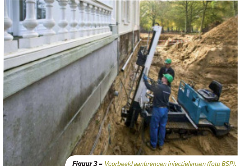
Figuur 3 – Voorbeeld aanbrengen injectielansen (foto BSP).
