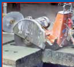
Betonboren en -zagen met diamant
