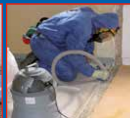
Asbestverwijdering
