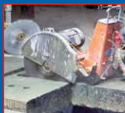
Betonboren en -zagen met diamant
