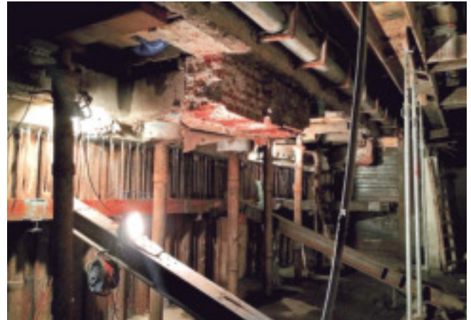
De ondergrondse constructie met diverse stempels.
