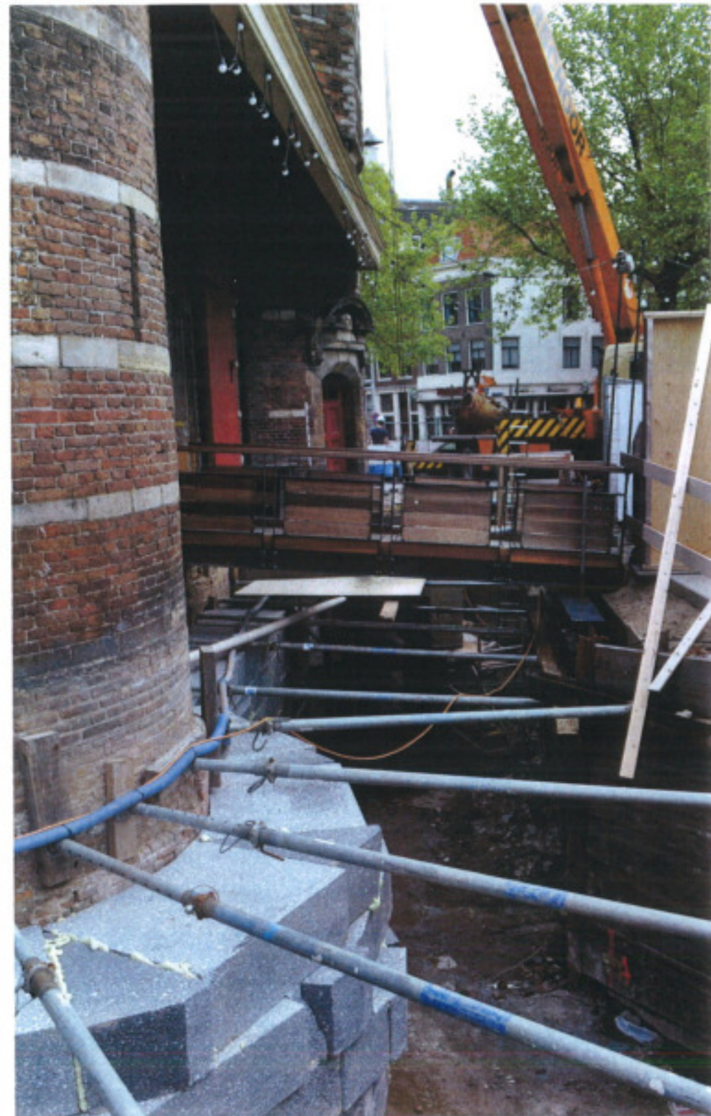
Ontgraving met Berliner wand langs de gevels (foto: Strackee)
